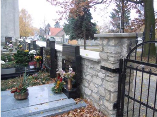
Beim Friedhof war die Einfriedungsmauer bereits in einem sehr desolaten Zustand und musste daher saniert werden. Im abgelaufenen Jahr konnten wir die Hälfte der Mauer neu verputzen und eine neue Mauerabdeckung herstellen. Die Sanierung der restlichen Mauer erfolgt 2013.
