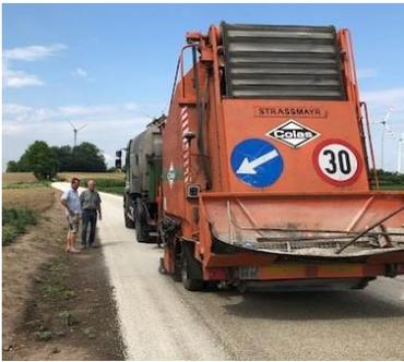
Da der Asphalt am Remiseweg (Verbindungsweg Pachfurth nach Bruck an der Leitha) schon in einem sehr schlechten Zustand war, wurde dieser heuer durch die Firma Colas mit einer Spritzdecke aus Teer und Kiesel überzogen, damit die Risse in der Asphaltschicht vor Wassereintritt geschützt sind.
