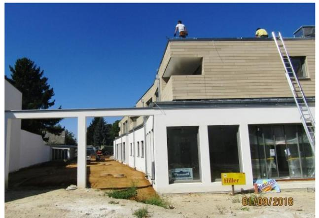
Herstellung des Unterbaues für die Nebenanlagen, sowie für die Flächen vor dem Müllraum und den Freiflächen im hinteren Bereich des Grundstückes.
